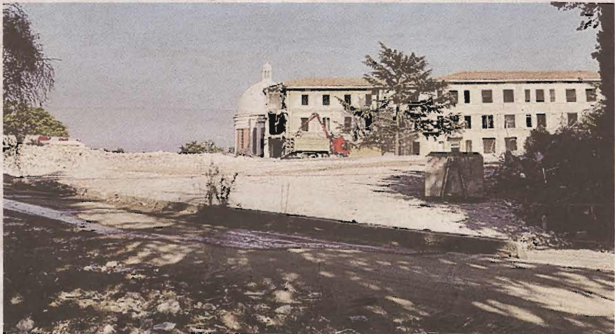
»» Una parte dell'area demolita dell'ex policlinico di Monteluce
